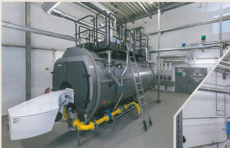
Hochdruck-Dampferzeuger in Low-NOx-Ausführung und thermische Vollentgasung
