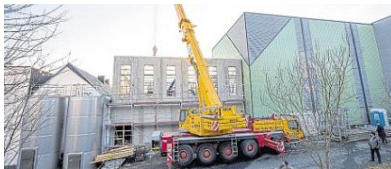
Die Arbeiten am neuen Sudhaus, das in den bisherigen Gebäudebestand aus einzelnen Sichtbetonteilen eingepasst wird, kommen gut voran.
